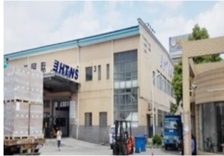
호치민 창고 전경
